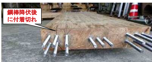
試験後の状況
