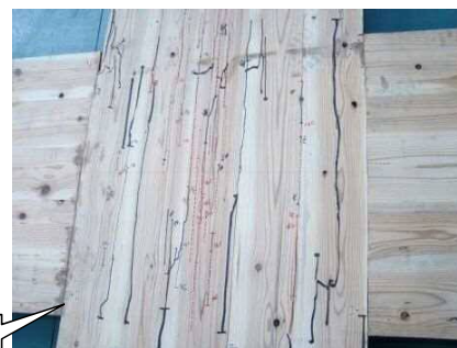
試験後の状況
